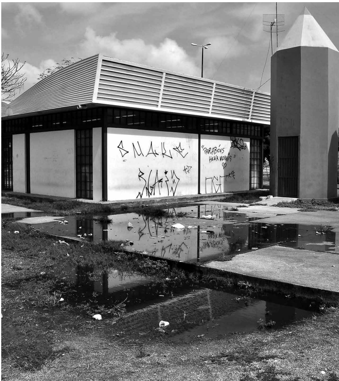
Esgoto estourado na Praça da Paz provoca mau cheiro no local e prejudica moradores e comerciantes
